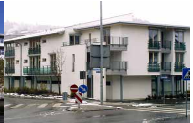
Neu bebaute Brache in Albstadt: Altenwohnungen
