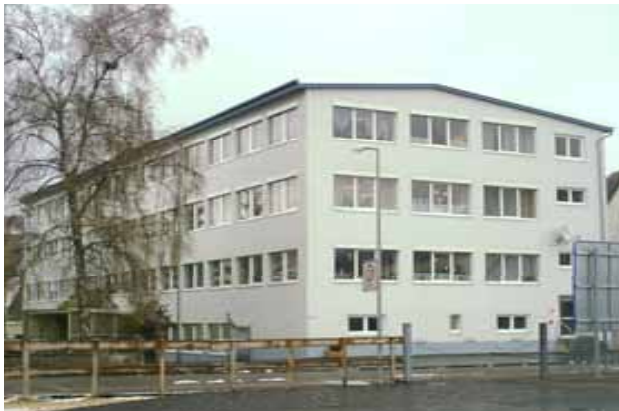
Umgenutztes Textilgebäude in Albstadt (Altenpflegeheim)
